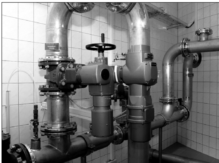
Das Pumpwerk in Reichardttsdorf
