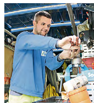
↑ Im Wasserwerk wird das Trinkwasser entsäuert, um alle Parameter der Trinkwasserverordnung einzuhalten. Michel Königer schaut hier, ob die Kreuzstrombelüftungsanlage ordnungsgemäß funktioniert.
