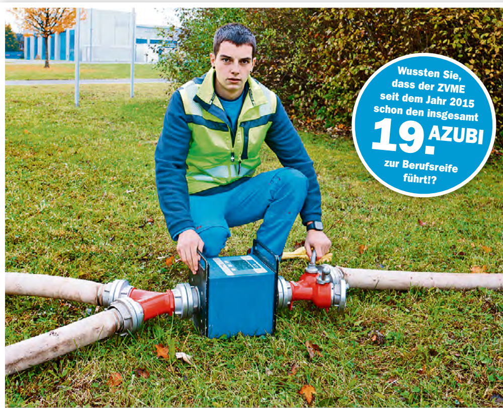
Wasserversorger Maurice Meinhardt prüft die Leistungsfähigkeit eines Hydranten.
