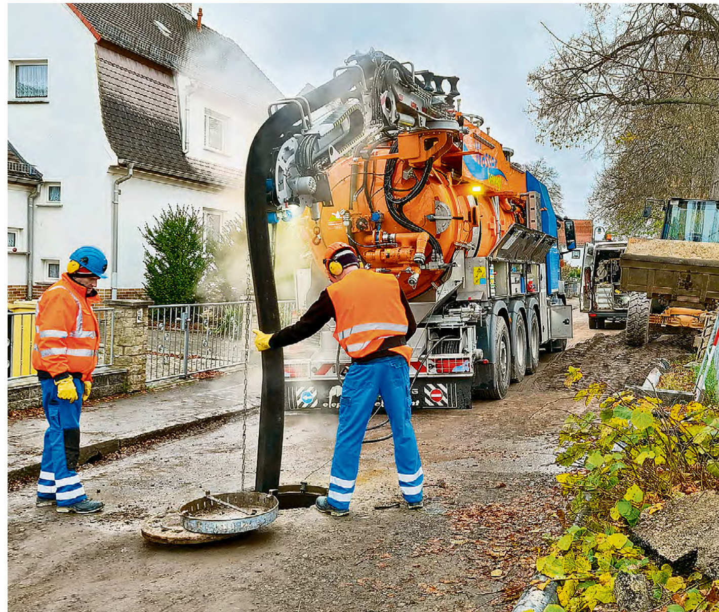
Werden Feuchttücher, Windeln oder Essensreste in der Toilette runtergespült, können die Abwasserkanäle verstopfen. Dann muss ein Team des ZVME ausrücken und den Kanal mit großem technischen wie finanziellen Aufwand reinigen. Foto: ZVME
