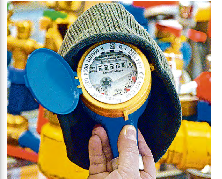
Wassermesser müssen im Herbst und Winter warm eingepackt werden, um vor Kälte geschützt zu sein. Foto: SPREE-PR / Fuchs
