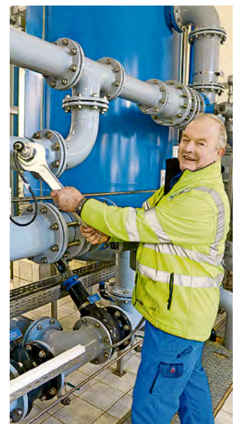
↑ Die technischen Anlagen, wie hier die pH-Wert-Sonde, müssen regelmäßig gereinigt und gewartet werden. Ralf Schüler legt schon mal Hand an.
