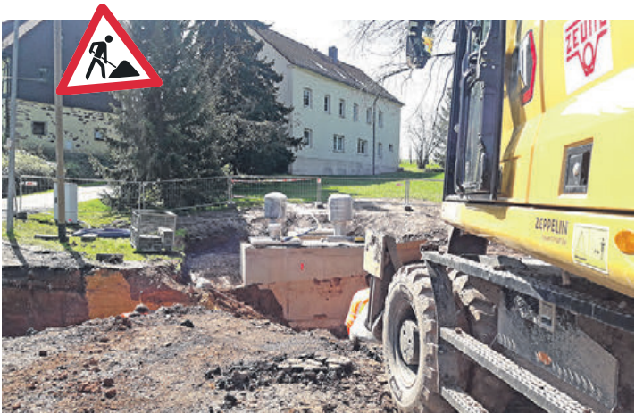
Hier entsteht die zentrale Abwasserpumpstation für die Ortslage Paitzdorf: Diese pumpt künftig das anfallende Schmutzwasser zur Kläranlage Ronneburg, dort wird es dann umweltgerecht gereinigt. Foto: ZVME
