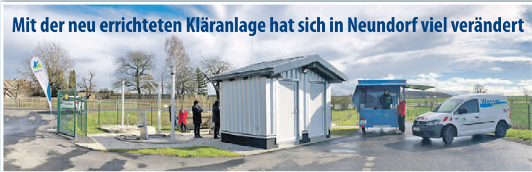
Die neue Kläranlage mit dem Betriebsgebäude, in dem das Fällmittel für die Abwasserbehandlung dosiert wird sowie die Technik ihren Platz hat. Gesamtkosten (inkl. des Regenrückhaltebeckens) für die Schmutz-, Niederschlags- und Trinkwasserleitungen im Ort: Rund 2,2 Mio. Euro, davon sind 620.000 Euro Fördermittel vom Land Thüringen.
