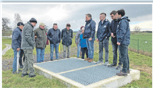
400 m³ Speichervolumen unter der Erde: Neundorf liegt in einer Senke. Bei Starkregen wird im Regenrückhaltebecken das Wasser gespeichert, später fließt es kontrolliert in den Neundorfer Bach ab. Der Ort ist somit vor Überflutung geschützt. Fotos (9): SPREE-PR/Wolf
