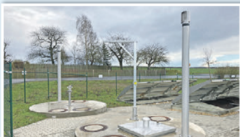
Vorklärbecken und Schlammfängerbehälter sind Bestandteil der neuen Kläranlage für die 118 Einwohner. Bauzeit war von 2020 bis Mitte 2022.
