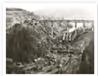
Der Bau der Bleilochtalsperre begann 1926.
