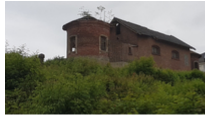
Dieser alte Flusswasserspeicher ist bereits abgerissen
