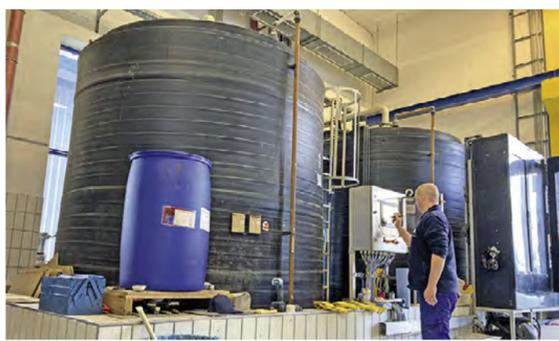
Wie hier auf der Kläranlage in Gera sorgt modernste Analysetechnik dafür, dass Fällmittel wie Eisen-III-Chlorid exakt dosiert und Phosphatgrenzwerte genau eingehalten werden.
