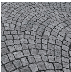
Verbundsteine mit wasserdurchlässigen Fugen
