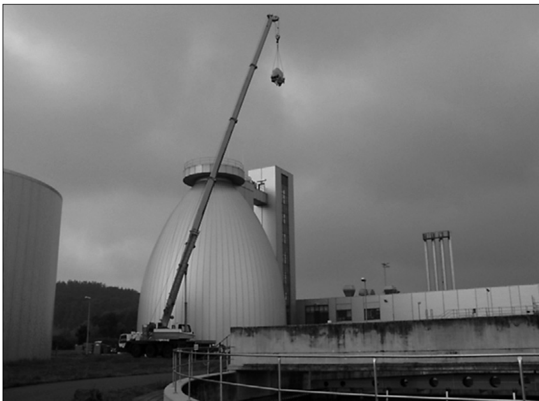
KW Gera 2007 Faulbehälter Sanierung abgeschlossen
