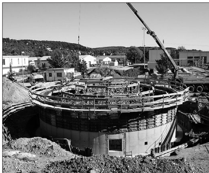
Ein Blick auf die Bauarbeiten im Klärwerk Gera
