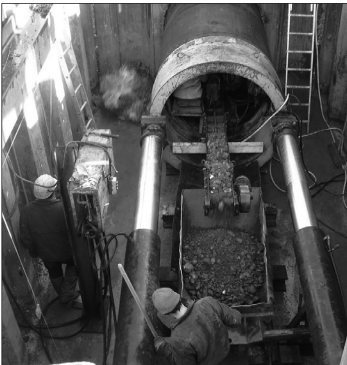
Startgrube mit bemanntem Rohrvortrieb im Bereich der Bahnquerung
